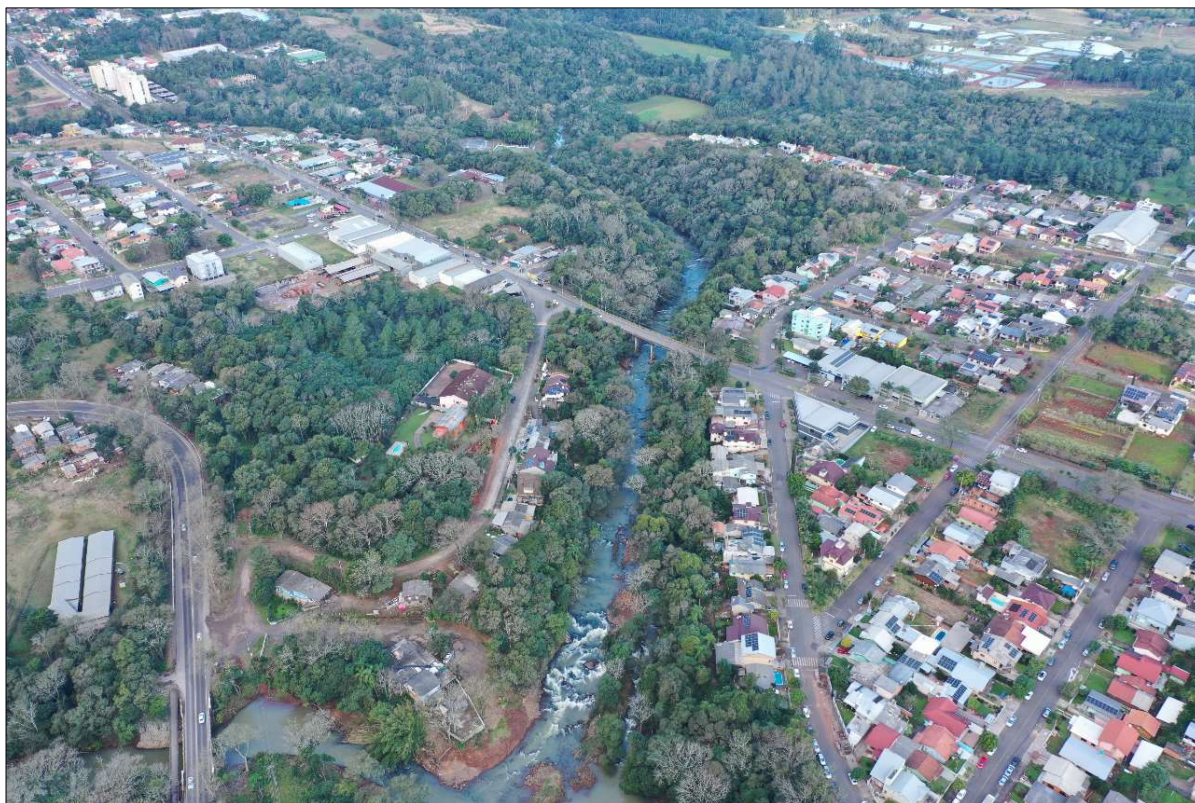
Figura 58 – Área de risco de alagamentos no encontro do Arroio feitoria com Arroio da Direita (ao fundo).
